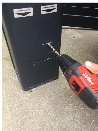
Perçage Ø 6,5mm
