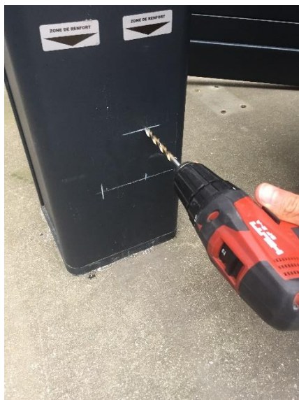
Perçage Ø 6,5mm
